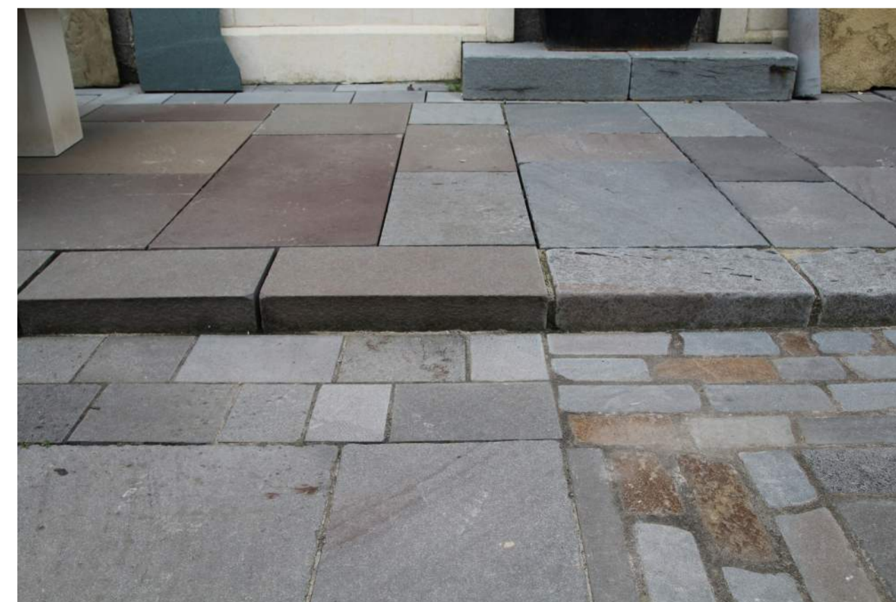
Esiaml o gerrig palmant yn defnyddio slabiau pennant Example paving using pennant slabs
